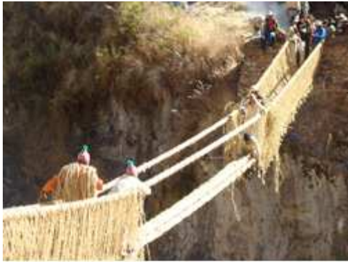
Les chakaruwaq ou « créateurs de ponts » en plein travail, Victoriano Arizapana et Hilario Cayo, membres de la communauté de Huinchiri. © Dirección de Registro y Estudio de la Cultura en el Perú Contemporáneo - Ministère de la culture
