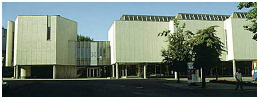
Figura 2 – O CAC ocupa a parte à esquerda da parede em vidro, enquanto, a LAA a parte à direita.
