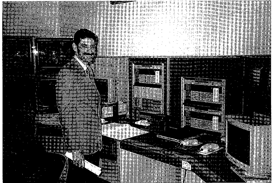
Control Centre. Photo: Leroux.
